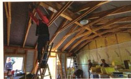
2013 ist dem Innenausbau gewidmet. Die Dämmung des Daches und die Verkleidung der Wände stehen auf dem Arbeitsprogramm der Hobbyimker.
